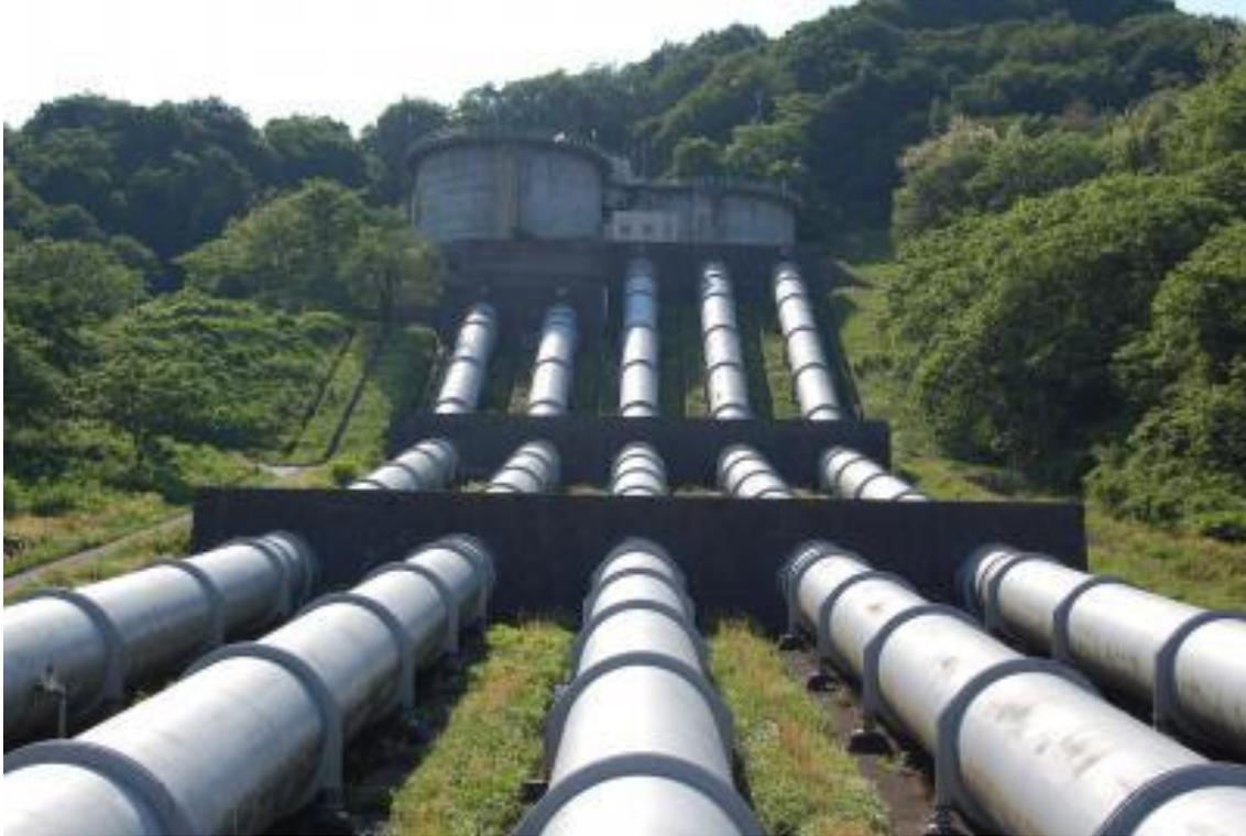
40 km上流より導水している累積発電量日本一の信濃川発電所管路
