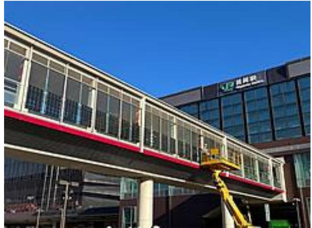
図 5-3 ガラス建材一体型太陽光パネル
