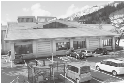
築30年を経過した「クアハウス津南」、今年はプール全体の天井張替を予算化
