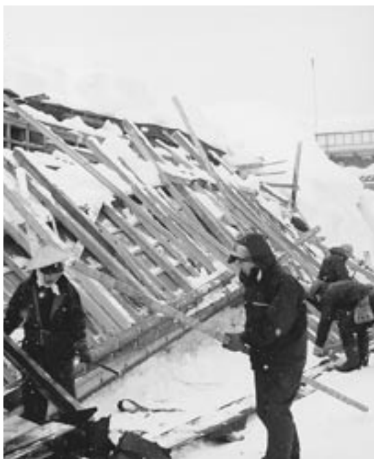
豪雪による屋根倒壊
