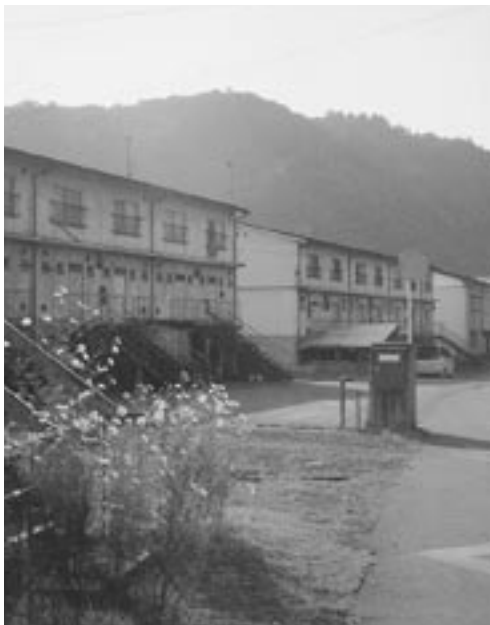
PFI事業が検討されている町営住宅
