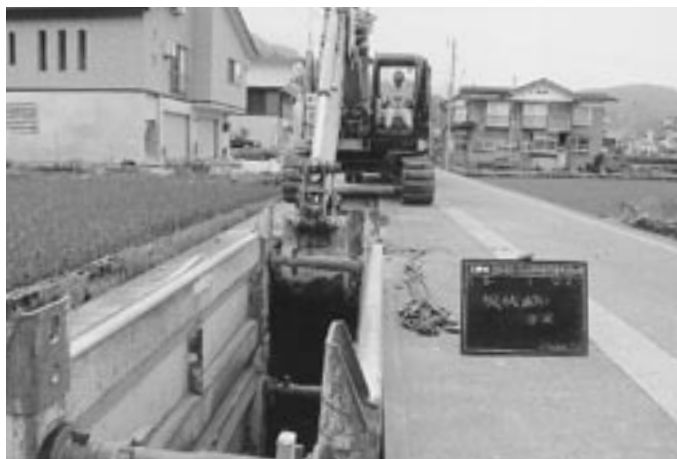
今年度完了に向け進められている下水道工事
