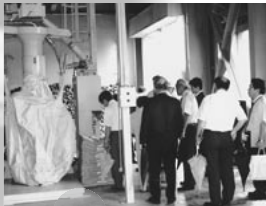
木質ペレット製造施設
